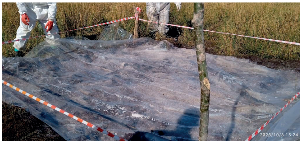
Рисунок 2 – Обрабатываемый участок накрыт полиэтиленовой пленкой
